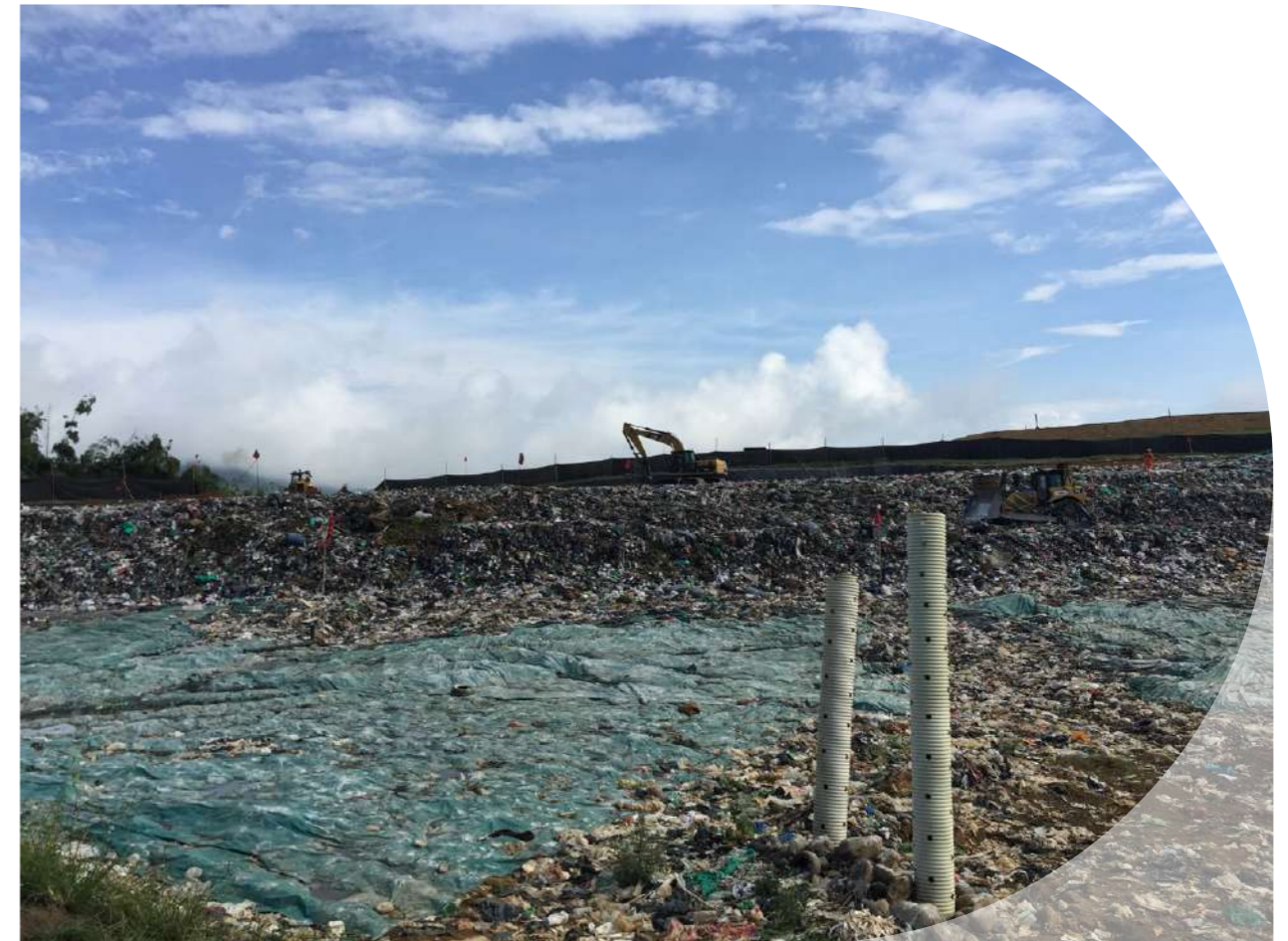
Imagen 14 Operación en vaso activo del relleno sanitario del municipio de Pereira en el 2019. Fuente: Banco de imágenes programa DEALS Pereira, 2017 – 2022.
