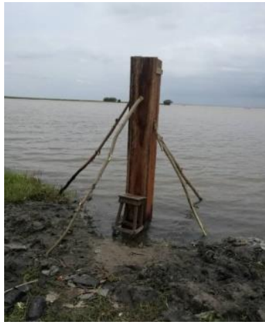
Poteau de balise coulé
